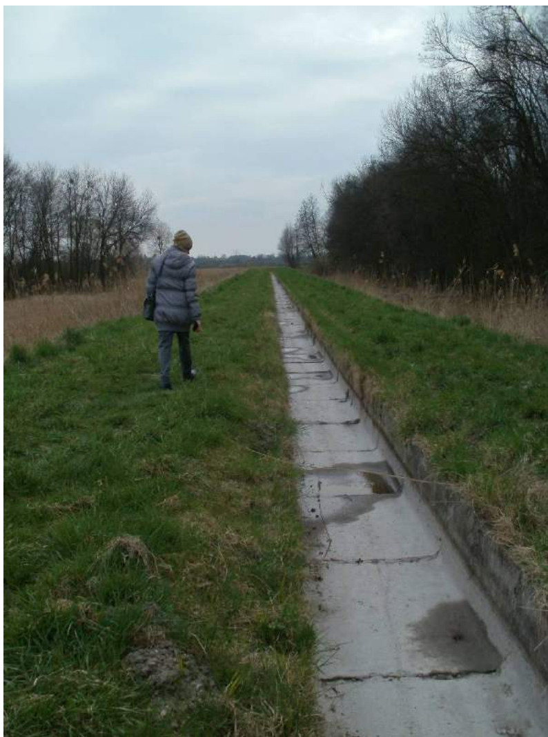
Fot. 8. Doprowadzalnik wody z rzeki Topornicy do zalewu miejskiego – pułapka dla drobnych zwierząt
